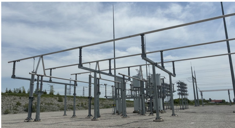
Installation existante en cours de déplacement
